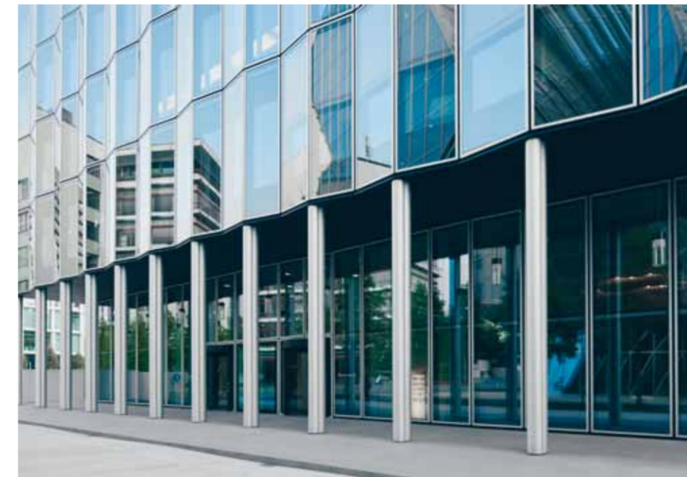
Elegant: der Eingangsbereich mit runden Säulenverkleidungen.
