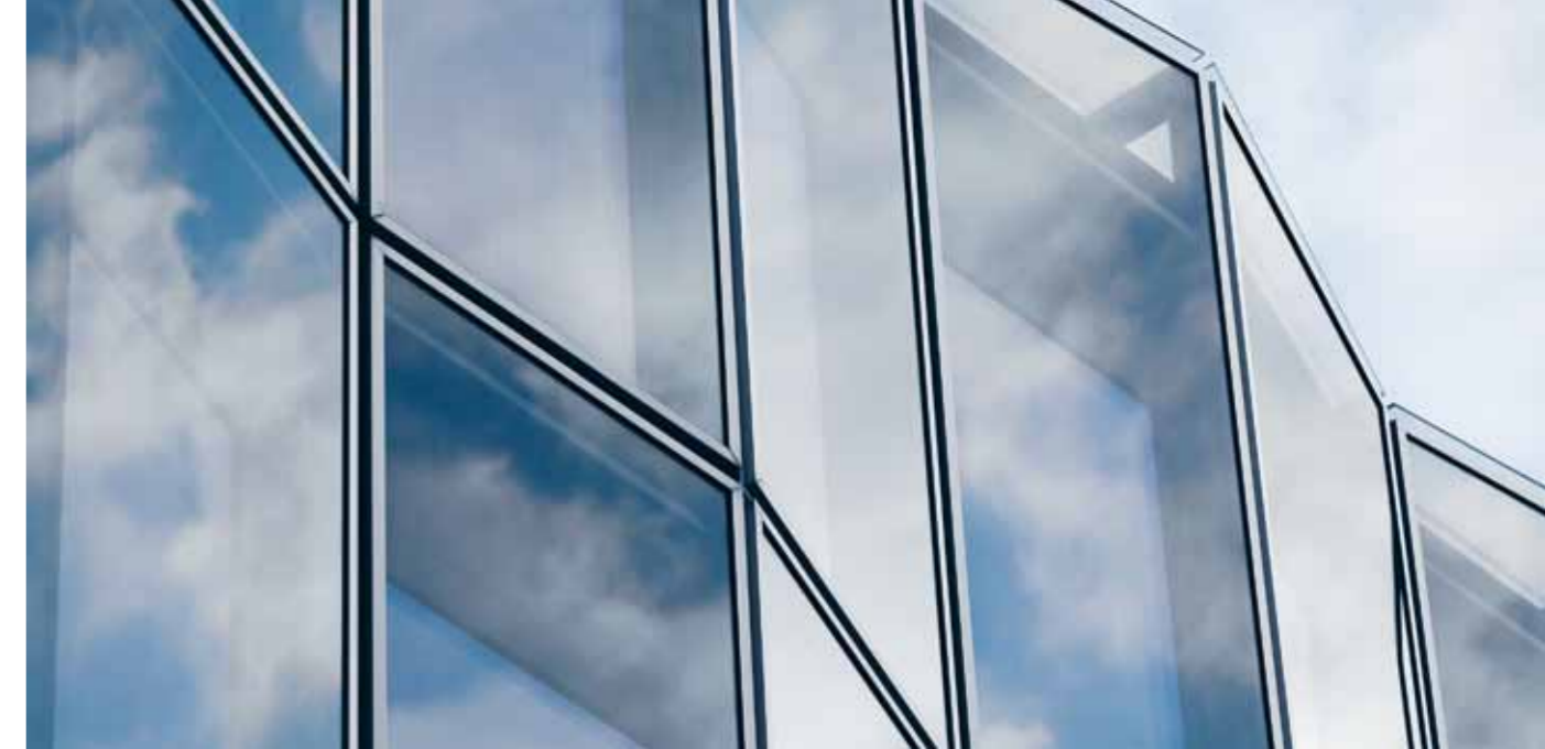
Jedes Fassadenelement besteht aus thermisch getrennten Aluminiumprofilen und beinhaltet eine dreifache Sonnen- und Wärmeschutzverglasung.
