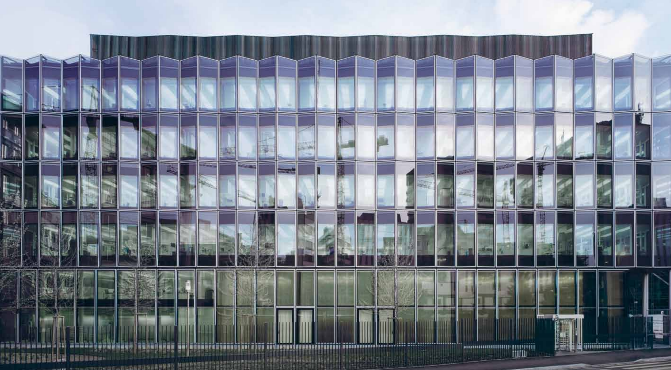
Die gefalteten, oszillierenden Doppelglas-Fassadenelemente wurden in einem geknickten Rastermass angeordnet, das einem «Faltenrock» gleicht.
