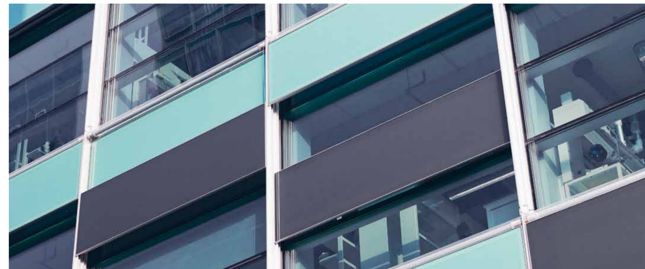
Die individuelle Beschattung der Fassade erfolgt über 460 abwechslungsweise angeordnete grüne und graue Glaselemente.
