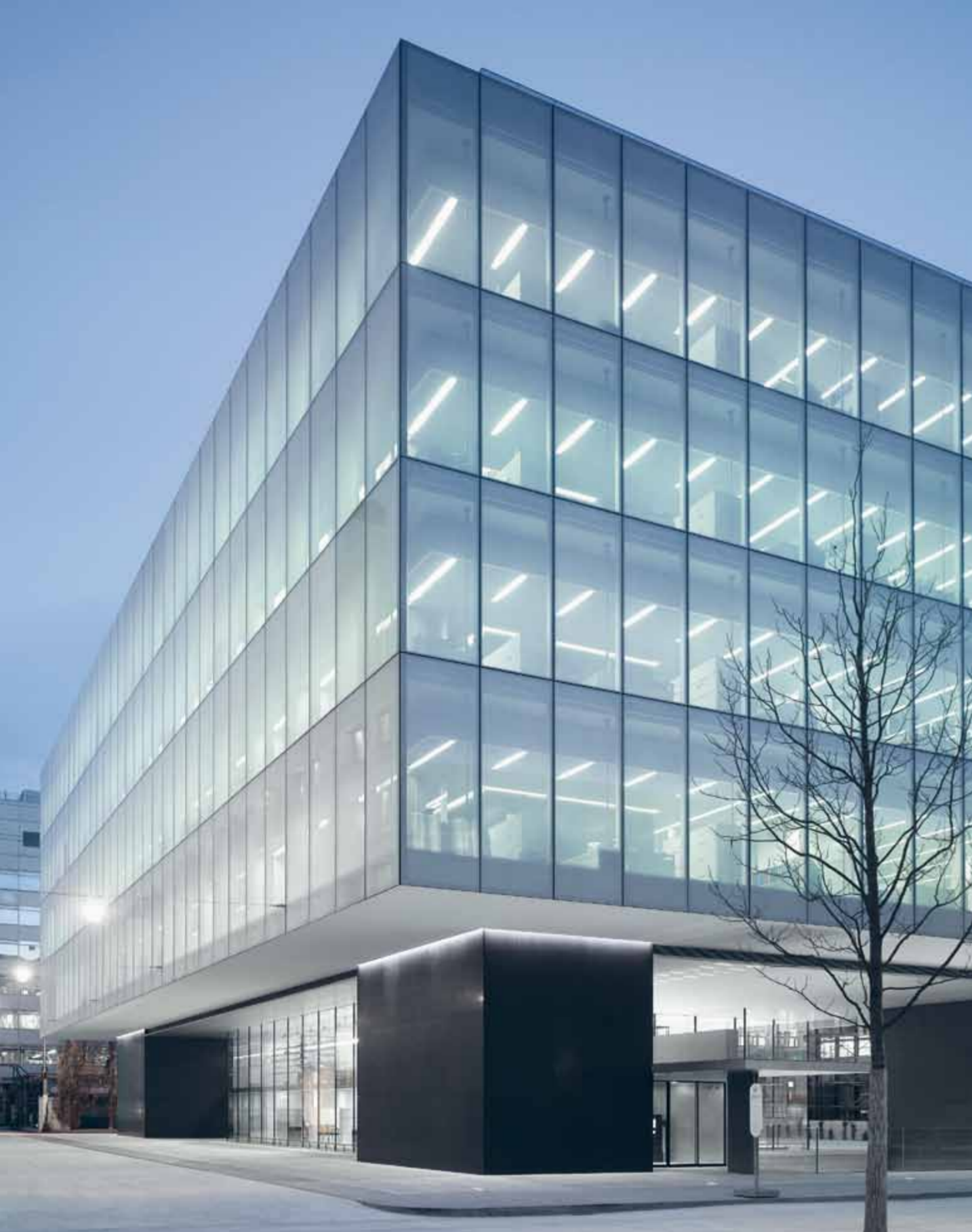
Das glatte Erscheinungsbild der Fassade – opak von aussen und transparent von innen – ergibt sich dank raumhoher Struktural-Silikon-Verglasung mit weisser, punktförmiger Siebbedruckung.
