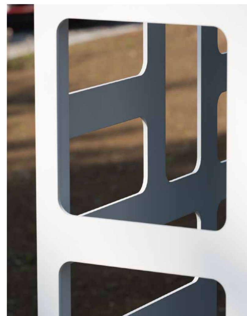
Klare Sicht von innen nach aussen, erschwelter Einblick von aussen nach innen: die spektakuläre «Schleierfassade» macht es möglich.
