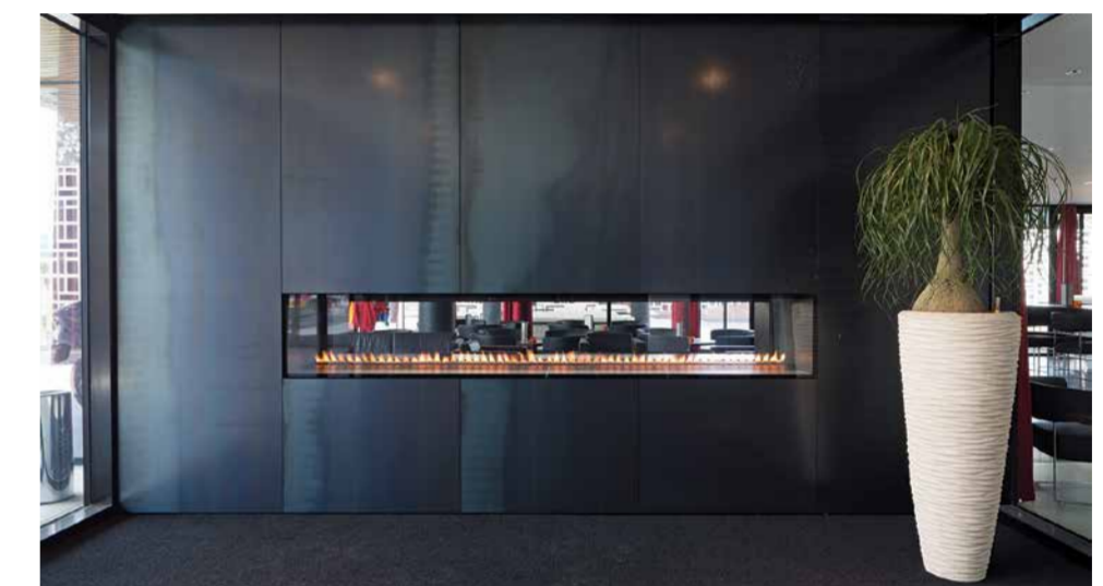
Grossflächige Elemente aus Schwarzblech im Innenbereich. Dank des Know-hows von Aepli Metallbau ohne sichtbare (und damit unschöne) Verschraubungen.
