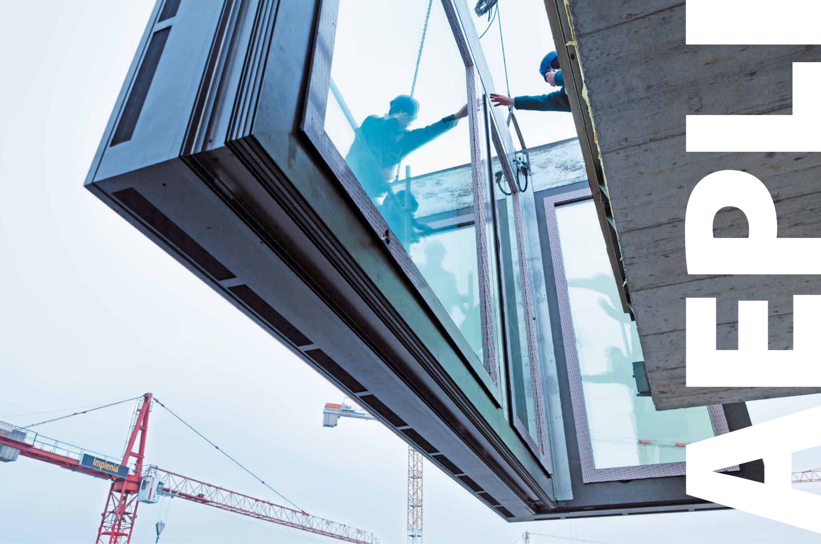
Wichtige Elemente bei der Innenmontage waren Effizienz und Umsicht.
