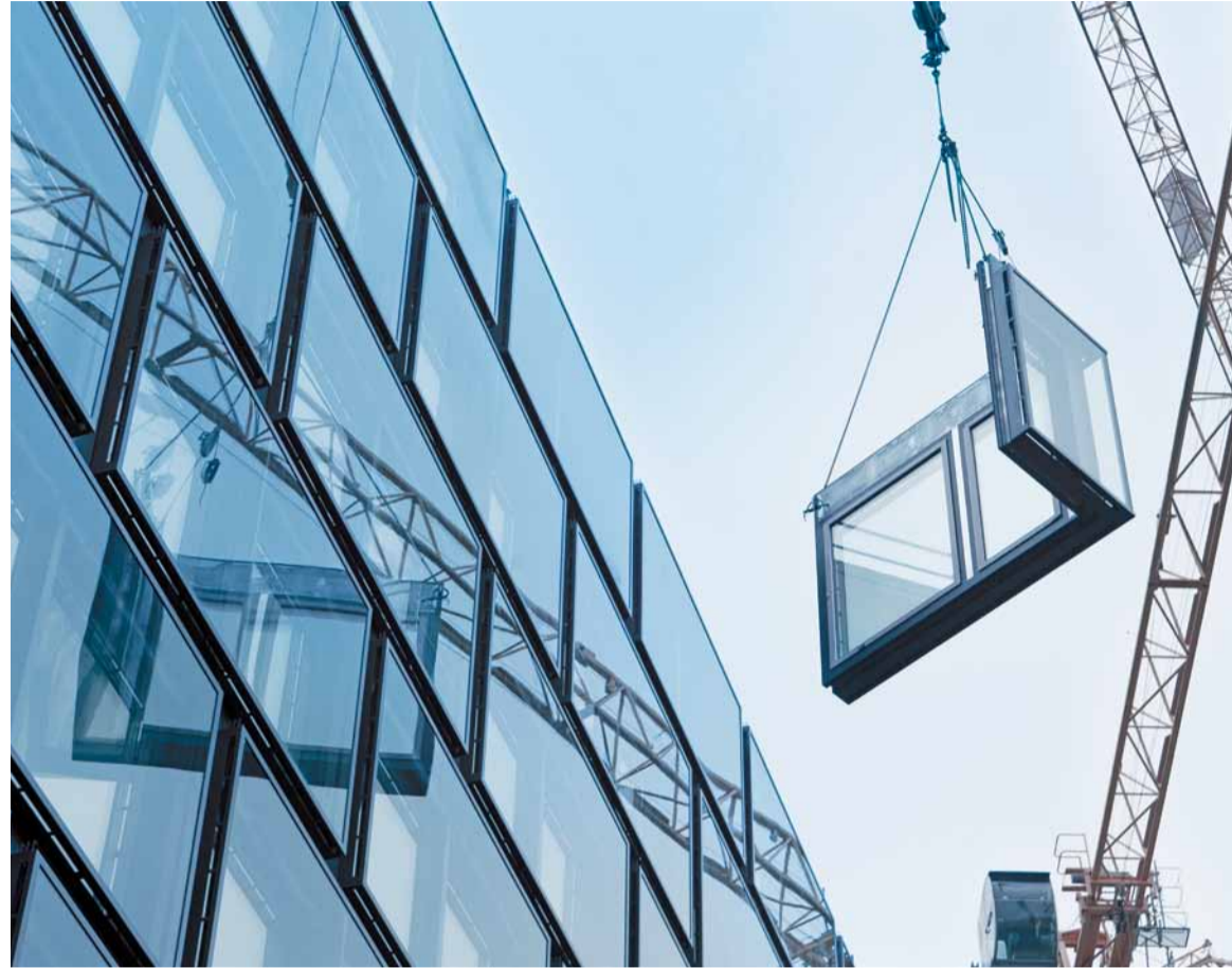
Das Zeitfenster für die Kräne musste genau eingehalten werden.
