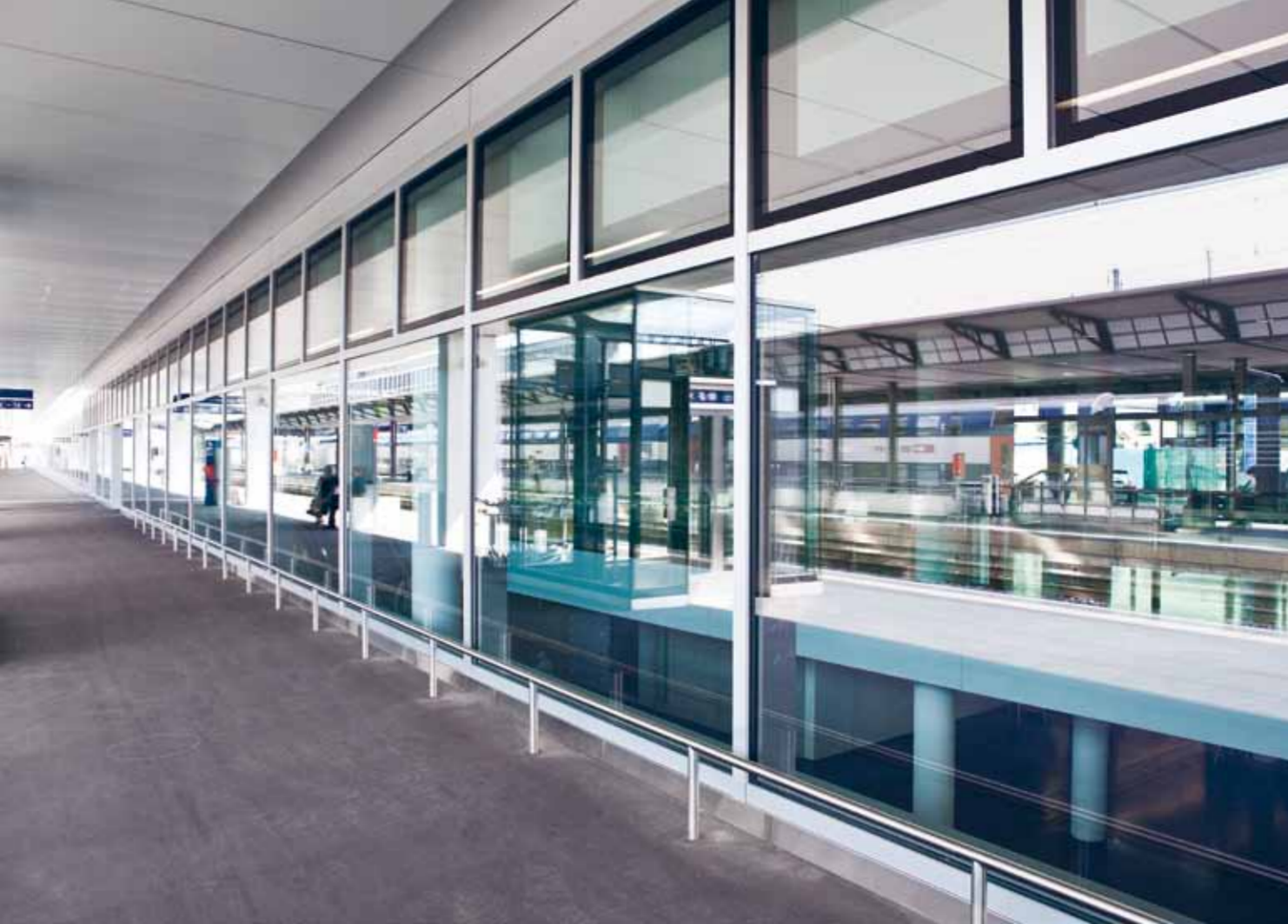
Alles von Aepli: Vertikalglasfassade sowie das Perrondach aus eloxiertem Aluminium.
