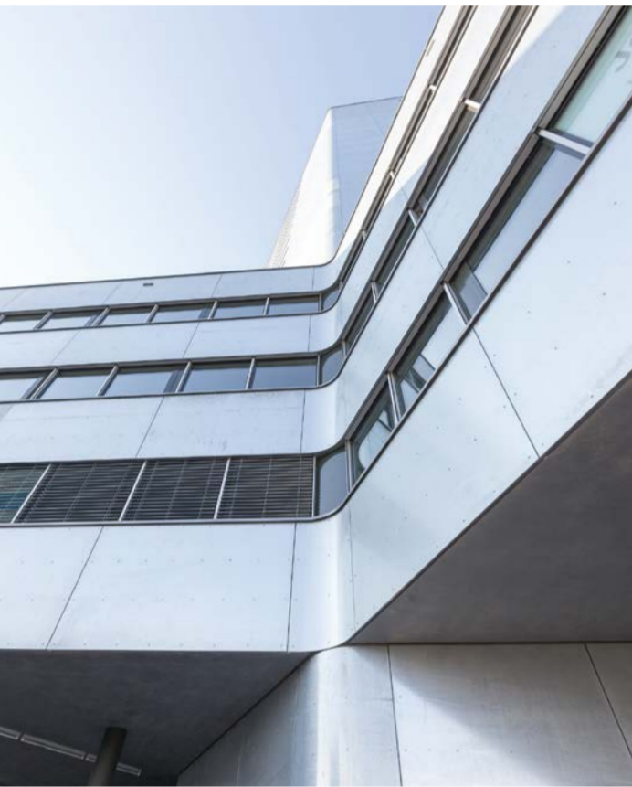
Eine Schweizer Pionierleistung: die einzigartige Gebäudehülle aus feuerverzinktem Stahlblech; ein Material, das allerhöchste Ansprüche an Verarbeitung und Montage stellt.
