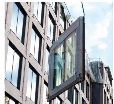
*Millimeterarbeit nach Mass, diese 370 Fassadenelemente mit Kalksteinverkleidung, einem Gewicht von jeweils 1,3 bis 1,5 Tonnen und den vielen unterschiedlichen Grössen.*
